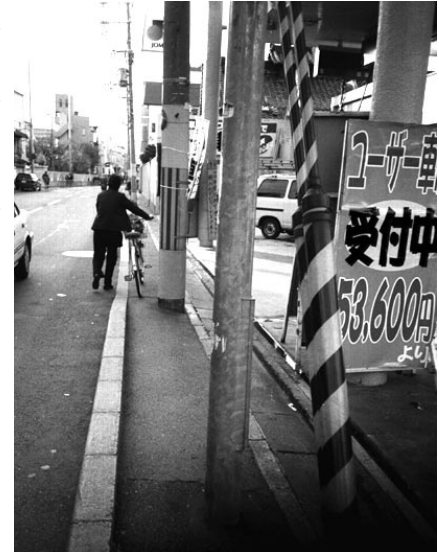
電柱2本が中央に鎮座する。人も自転車も通る余地がない。(高辻通大宮西入ルで)
